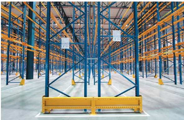
Фото 2 Защита торцевой части ряда стеллажей
